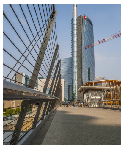
Ponte Gioia, Milano
